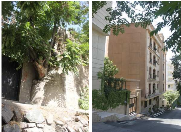
تصاویر ۶: کرسی چینی برای هم‌سطح سازی در واحدهای قدیمی و استفاده از پله در واحدهای جدید (کاشانک)
