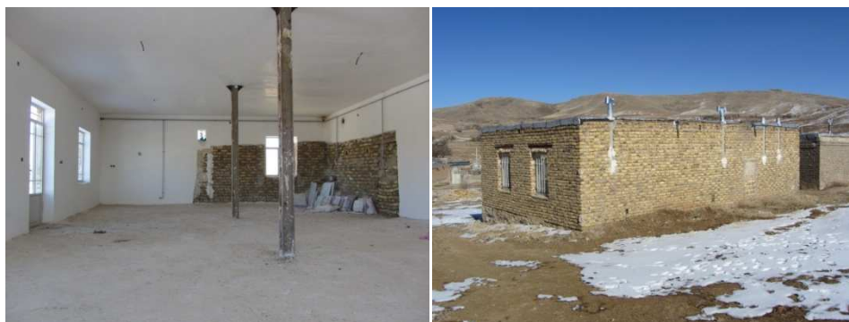
تصویر ۵: نمای داخلی یک واحد مسکونی جدید تصویر ۶: نمای بیرونی مسکن جدید الحداث
